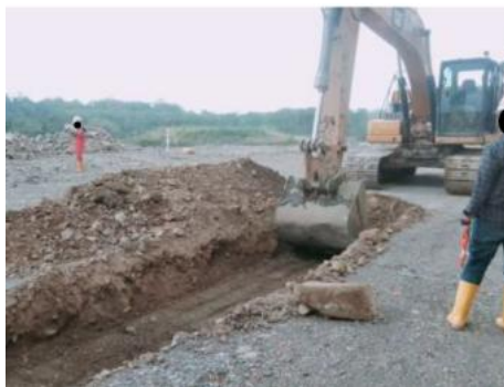
Gambar 1. Penggalian Lubang Uji
